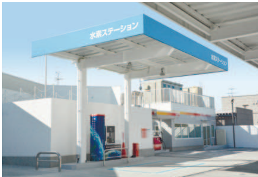
「エネルギーPark郡山南」に設けられた水素ステーション
